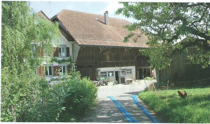
Das Wohnhaus des Gemeinschaftshofs Gabris.
